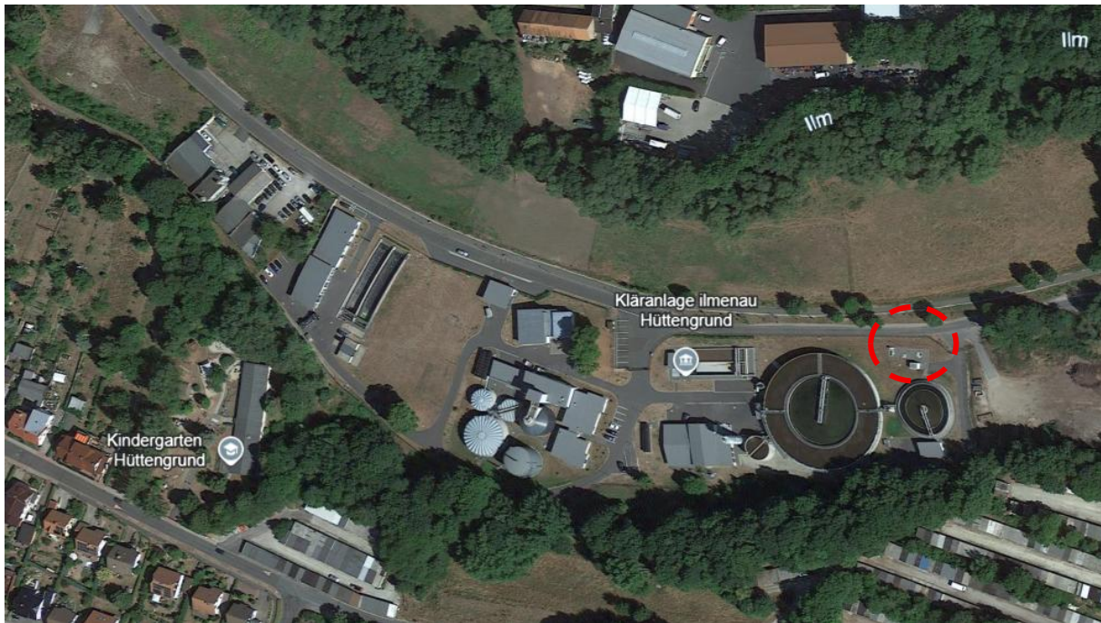
Abbildung 27: Kläranlage Ilmenau und Lage Abwasserablauf
